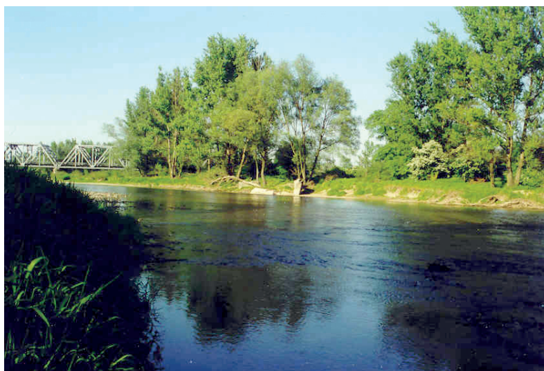
II. A.18. Koryto Soły w rejonie Żywca z odsłoniętą częścią koryta głównego, częściowo piaszczystego, a częściowo pokrytego trawą
