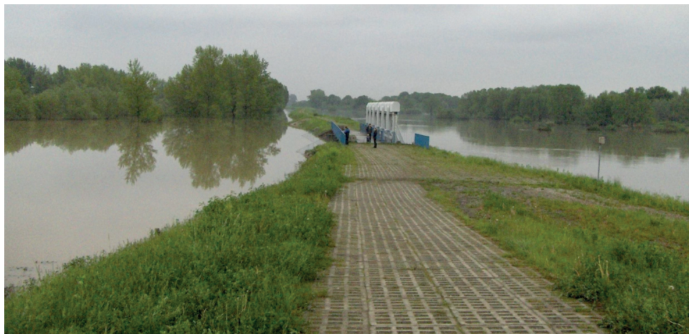
II. 2.12. Napelniony polder Buków (widok w rejonie jazu). Według RZGW w Gliwicach
