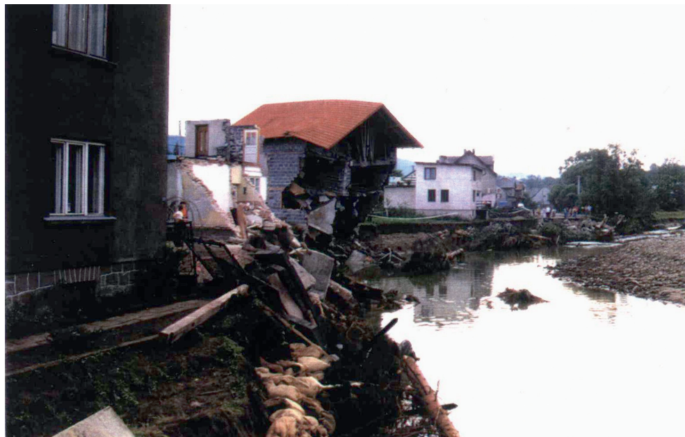
Il. 1.32. Podmyte brzegi rzeki i zniszczona zabudowa przybrzeżna w powiecie żywieckim na skutek powodzi w 1997 r.
