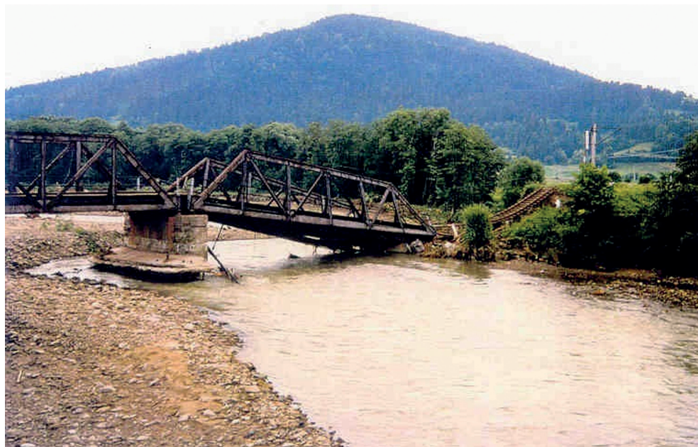
Il. 1.33. Podmyty brzeg rzeki Soły i zniszczony most kolejowy w Milówce na skutek powodzi w 1997 r.
