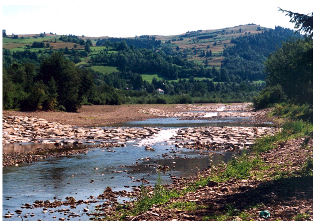
Fot. 3.12. Regulacja koryta Porębianki w Podobinie za pomocą ramp kamiennych, wykonana w 2004 r. (fot. J. Korpak)
