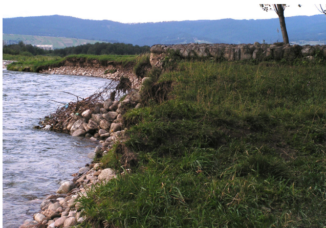
Fot. 3.1. Pogłębione koryto Białego Dunajca na odcinku uregulowanym za pomocą ostróg siatkowo-kamiennych (fot. J. Korpak)
