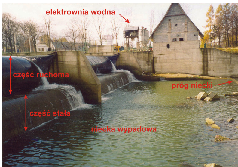
Fot. 3.3. Jaz ruchomy z elektrownią wodną w Szaflarach na Białym Dunajcu (fot. J. Korpak)
