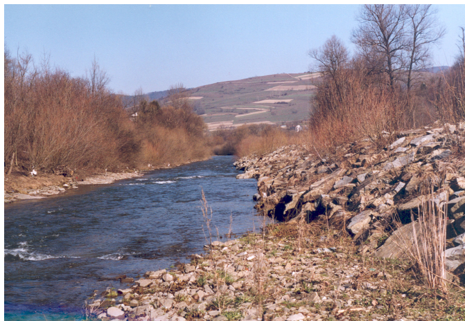
Fot. 3.2. Opaska z narzutu kamiennego z wikliną w korycie Mszanki (fot. J. Korpak)
