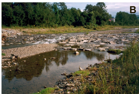
Fot. 3.10. Koryto Mszanki w Mszanie Dolnej, uregulowane w 2003 r. korekcją stopniową (A), i koryto Porębianki w Podobinie, uregulowane w 2004 r. za pomocą ramp kamiennych (B) (fot. J. Korpak)
