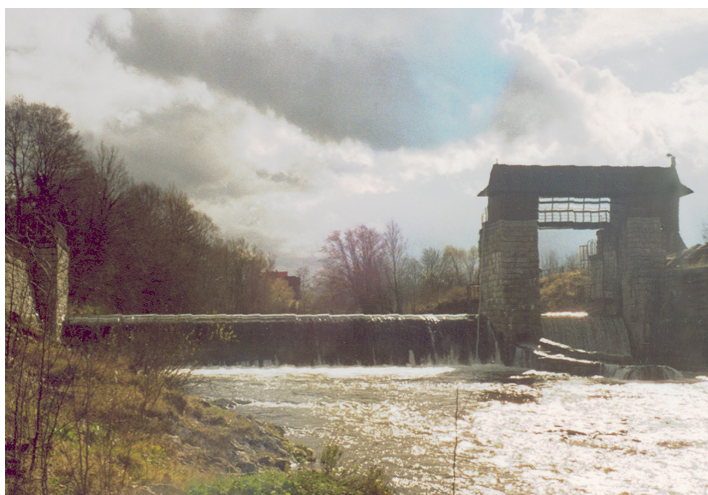
Fot. 3.13. Jaz w Szaflarach I, wykonany przed 1970 r. (fot. J. Korpak)
