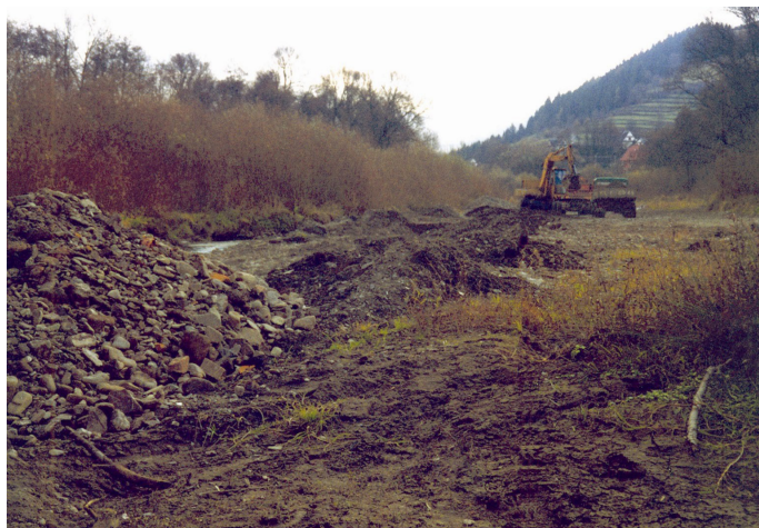
Fot. 3.5. Eksploatacja rumowiska ze zbiornika zapory przeciwrumowiskowej w Mszanie Górnej I, wypełnionego po wezbraniu w 1997 r. (fot. J. Korpak)
