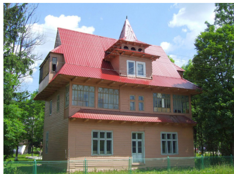
Il. 58. Pensjonat „Ada”, widok od północnego zachodu, 2007 r.
