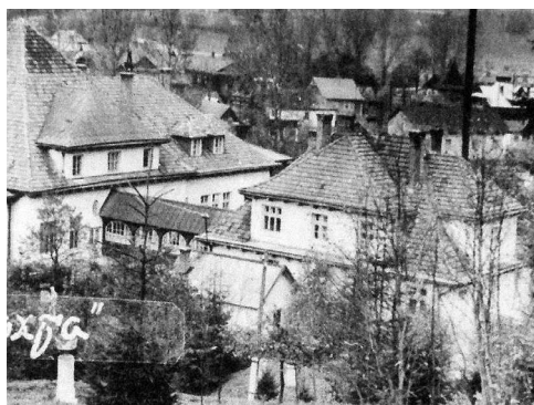
Il. 34. Dom Zdrowia Kolejarzy, budynek przybudowany do wschodniej elewacji domu kolonijnego dzieci kolejarskich, widok od południowego wschodu, lata 60. XX w. Źródło: archiwum Jacka Czubińskiego
