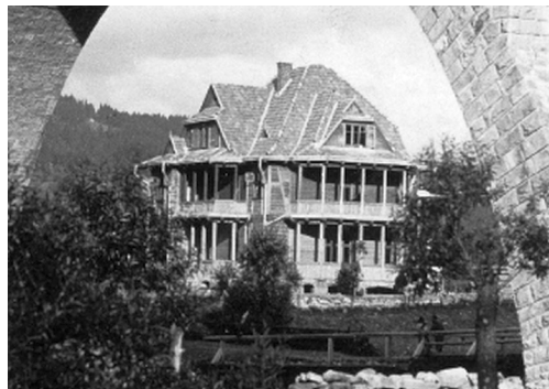
II. 43. Pensjonat „Ustronie” w trakcie budowy, widok od północnego zachodu, 1927 r. Źródło: Fragment pocztówki z podpisem: Worochta. Pensjonat Ustronie. Narodowe Archiwum Cyfrowe, sygn. 3/1/0/8/3579
