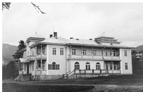
Il. 67. Pensjonat „Oaza” („Belweder?”), widok od południowego zachodu, 1932 r. Źródło: fragment pocztówki, fot. Adolf Błaż, 1932 r., Biblioteka Narodowa, sygn. DŹS XII 8b/p.91/1. Poczt. 10166
