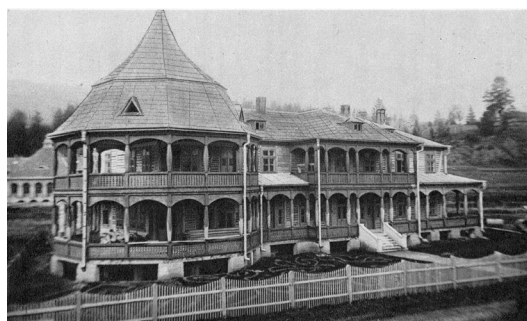
Il. 63. Pensjonat „Warszawianka” w trakcie budowy w 1926 r., widok od północnego zachodu.
