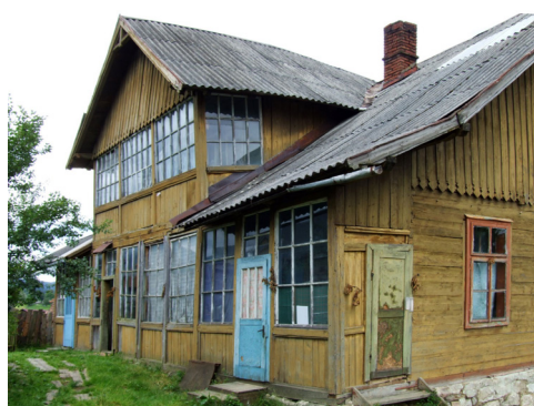
II. 3. Pensjonat „Howerla”, widok od północnego zachodu, 2008 r. Fot. Jacek Czubiński
