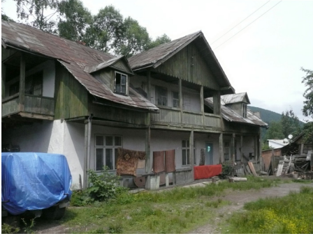
Il. 16. Budynek przy ul. D. Halickiego 34, 2012 r. Fot. Jacek Czubiński
