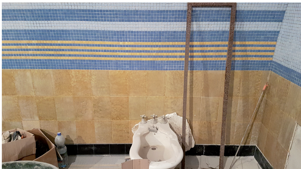
II. 27. Ściana po rekonstrukcji płytek. Fot. Wojciech Szkodlarski
