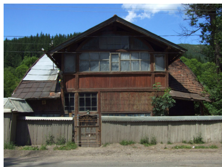
Il. 9. Dawne Schronisko Kolejowego Przystosobienia Wojskowego, 2009 r.
