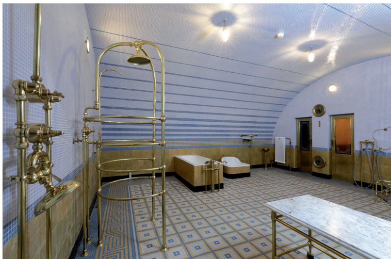
Il. 43. Gotowe zamontowane repliki natrysków w odnowionym pomieszczeniu łaźni. Fot. Atelier Fotograficzne DUET
