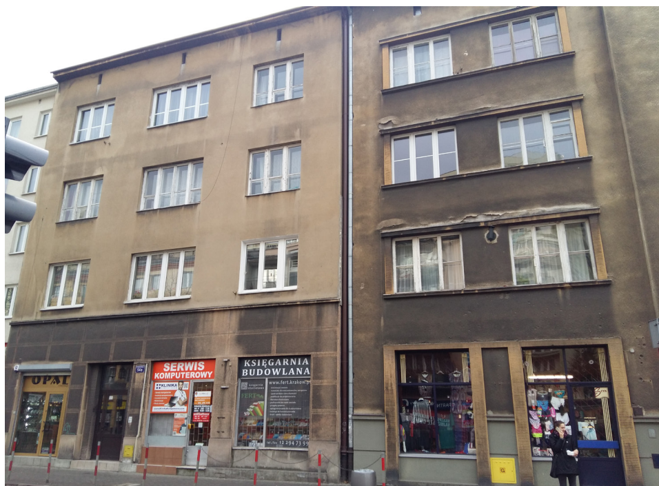
Il. 2. Na zdjęciu widać podział fasady na część dolną (cokołową) i górną, wyróżnione rodzajem tynku – w dolnej kamieniarskiego, w górnej tynku droбноziarnistego, zacieranego na gładko.
