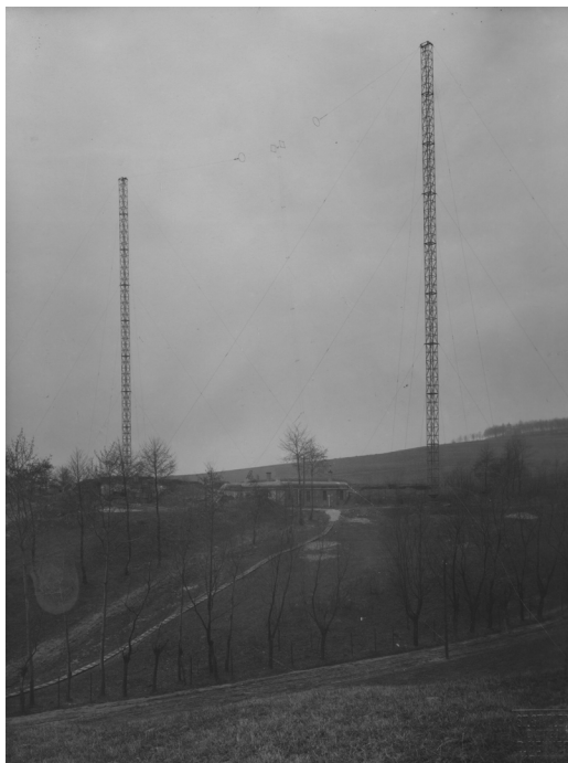
II. 7. Maszty antenowe i budynki na terenach pofortecznych (fort 1 „Zwierzyniec”), 1927. Źródło: fotografia ze zbiorów Narodowego Archiwum Cyfrowego, sygnatura 1-K-1261-5
