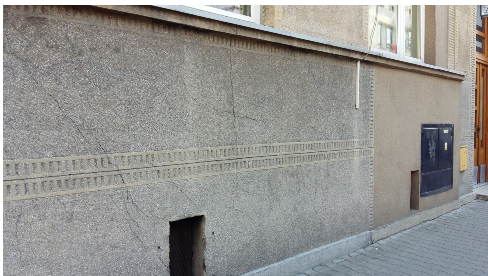
Il. 4. Tynk kamieniarski – stosowany był w dolnych partiach fasad budynku. Na ilustracji widoczny jeden z wielu sposobów opracowania, tu jako podział na poziome pasy imitujące płyciny kamienne z wykończeniem nawiązującym do tzw. szlaku krakowskiego, tj. krawędzie ryflowane, zaś powierzchnie płyt z fakturą rwaną. Fot. M. Bogdanowska
