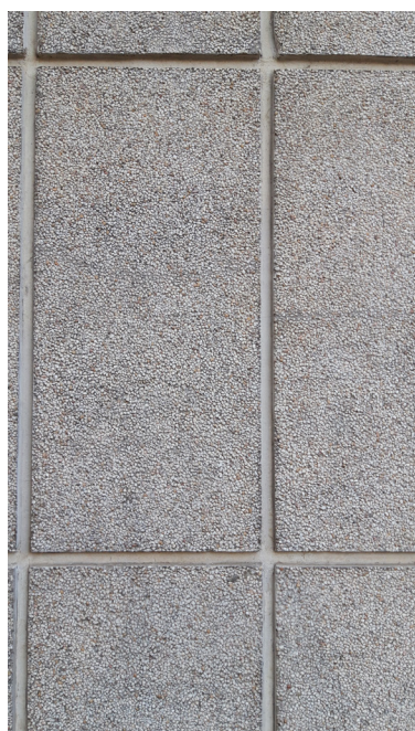
Il. 2. Na zdjęciu widać podział fasady na część dolną (cokołową) i górną, wyróżnione rodzajem tynku – w dolnej kamieniarskiego, w górnej tynku droбноziarnistego, zacieranego na gładko.
