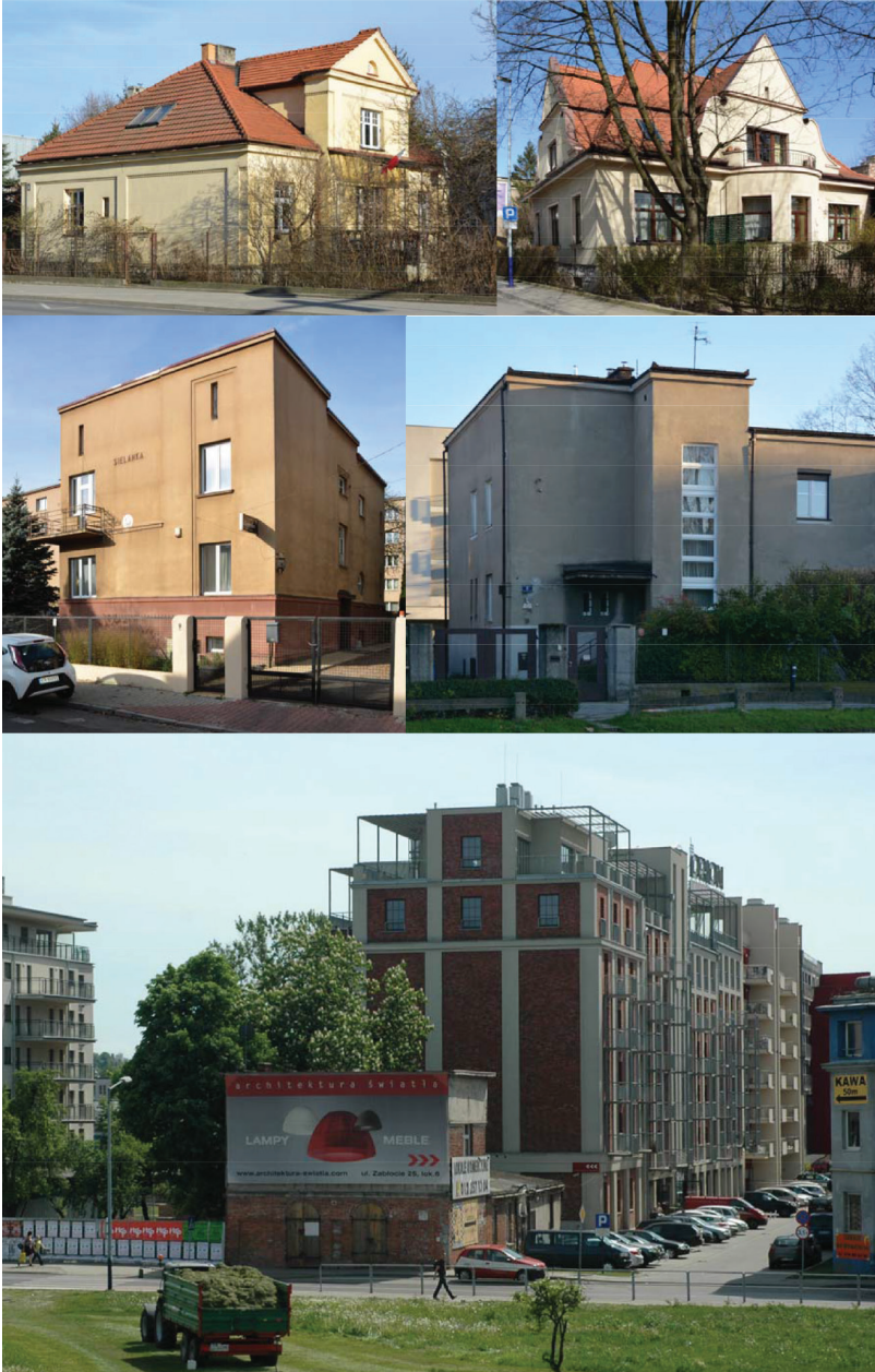
II. 38. Przykłady domów wolnostojących oraz zespołu przemysłowego, zaprojektowanych przez budowniczych krakowskich. A – dom sędziego przy ul. Olszyny 1 (proj. Józef Wilczyński). B – dom jednorodzinny Żeremie przy ul. Olszyny 8 (proj. Stanisław Mehl i Kazimierz Baranowski). C – dom Sielanka przy ul. Narzymskiego 28 (proj. Stanisław Turek Kryłoszański). D – dom lekarza przy ul. Olszyny 9 (proj. Kazimierz Baranowski). E – zabudowania d. fabryki Ziarno (w głębi budynek młyna, proj. E. Skawiński; przed nim budynek administracyjny, proj. A. Dostał), w latach 2008–2011 adaptowane na zespół mieszkaniowy z usługami (proj. arch. Ludomir Książek). Fot. Maciej Motak, 2010–2018
