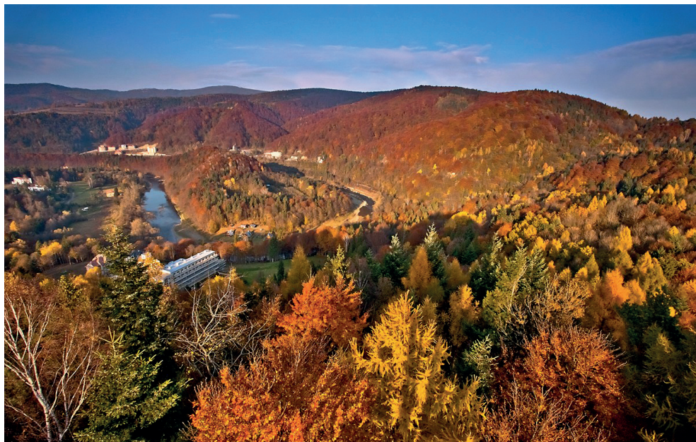
II. 34. Widok na uzdrowisko Żegiestów-Zdrój utopione w lasach Beskidu Sądeckiego. Na pierwszym planie Łopata Polska z sanatorium Wiktor, w tle centrum założenia uzdrowskiego, na lewo od centrum, odremontowane sanatorium Warszawianka i nowe obiekty pensjonatów wznoszone w ostatnich latach. Źródło: http://muszyna.pl/ (dostęp: 20.05.2020)
