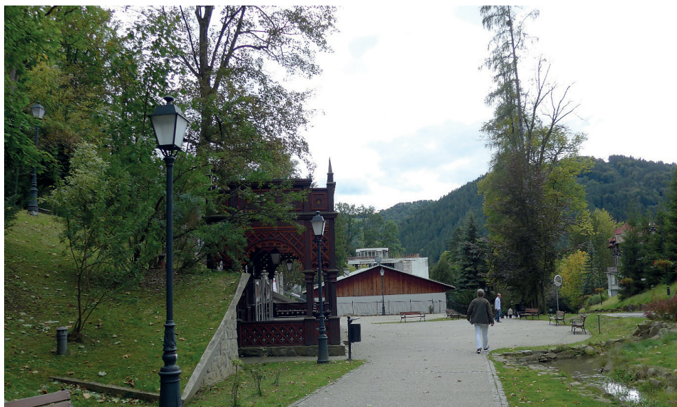
II. 47. Fragment głównej promenady łączącej Dolny Park Zdrojowy i miasto z centrum uzdrowiska przy placu Dietla i Górnym Parku w Szczawnicy; po prawej stronie odbudowana pijalnia wody Magdalena, a w głębi obecnie popadający w ruinę modernistyczny zakład przyrodolecznicy, po lewej odtworzony potok szczawnicki w górnej części promenady. Fot. E. Węclawowicz-Bilska, 2018
